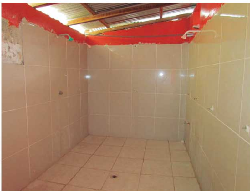
Trabajos de mejora de servicios higiénicos - ETS PNP de Cajamarca
