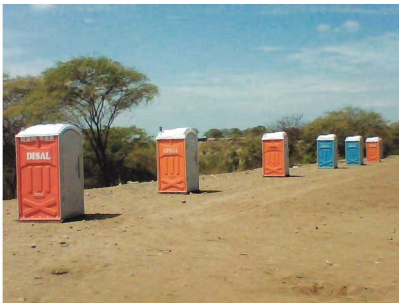
Instalación de baños portátiles – ETS PNP de Sullana
