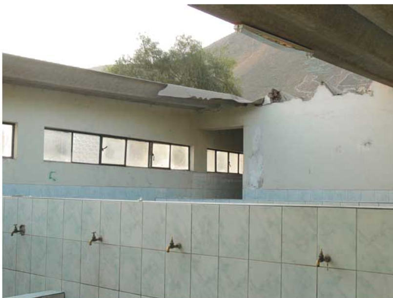
Lavaderos - ETS PNP de Puente Piedra
